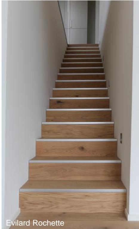
Hervorheben der Stufenvorderkanten durch Zusatzsysteme um Stolpern und oder Abrutschen an der Kante zu vermeiden. Antritte und Austritte heben sich vom restlichen Bodenbelag kontrastreich ab.
