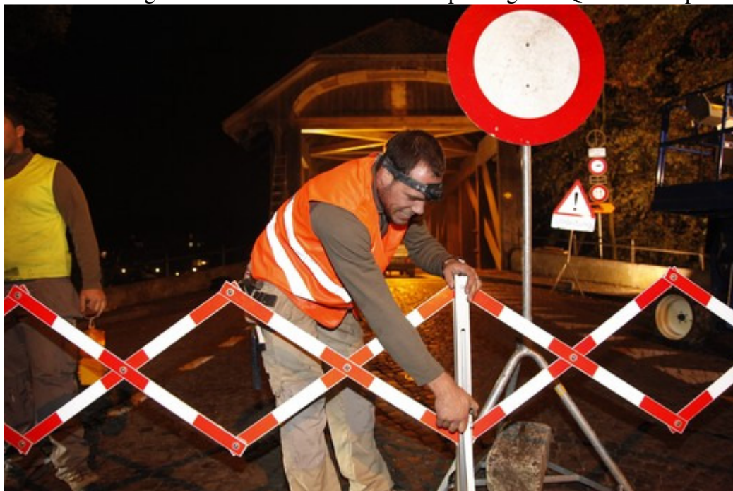
Fünf Nächte war die Holzbrücke wegen der Reparaturarbeiten gesperrt Quelle: Hanspeter Bärtschi
