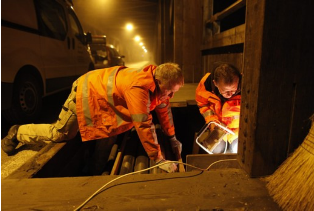
Auch der Zustand der Brücke wurde unter dem Trottoir kontrolliert Quelle: Hanspeter Bärtschi
