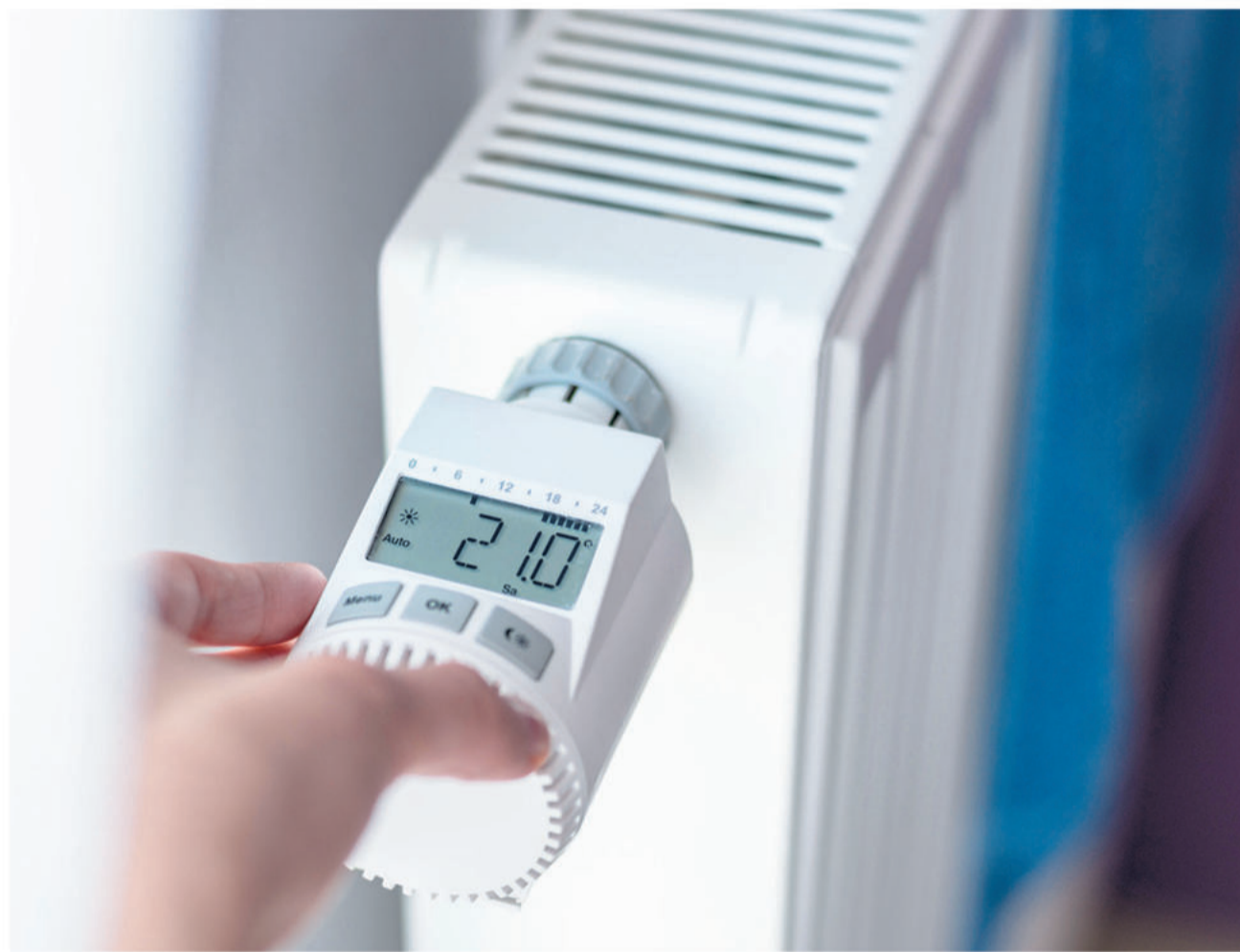
Vom Energieverbrauch in Haushalten entfallen rund 67% auf die Heizung und 17% auf die Warmwasserproduktion.
