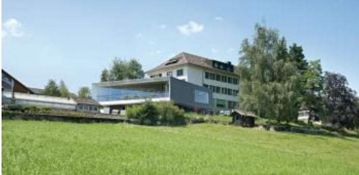
Südostansicht, vom Tal her gesehen, mit der offenen Loggia
