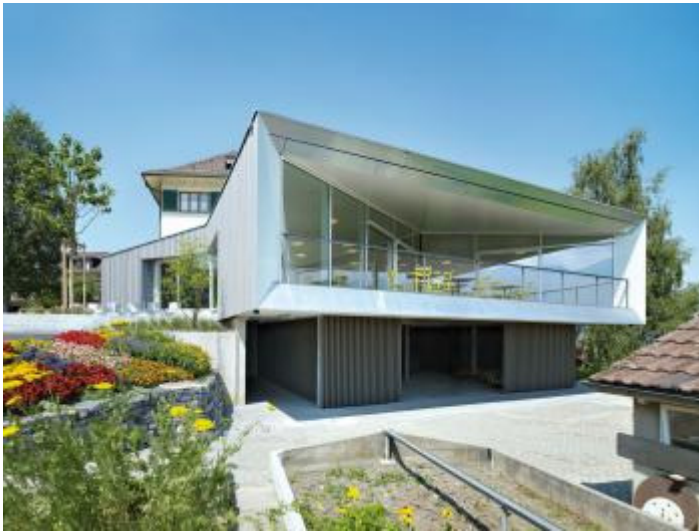
Blick von der Zufahrt her auf Loggia und Eingang ins Restaurant (links)
