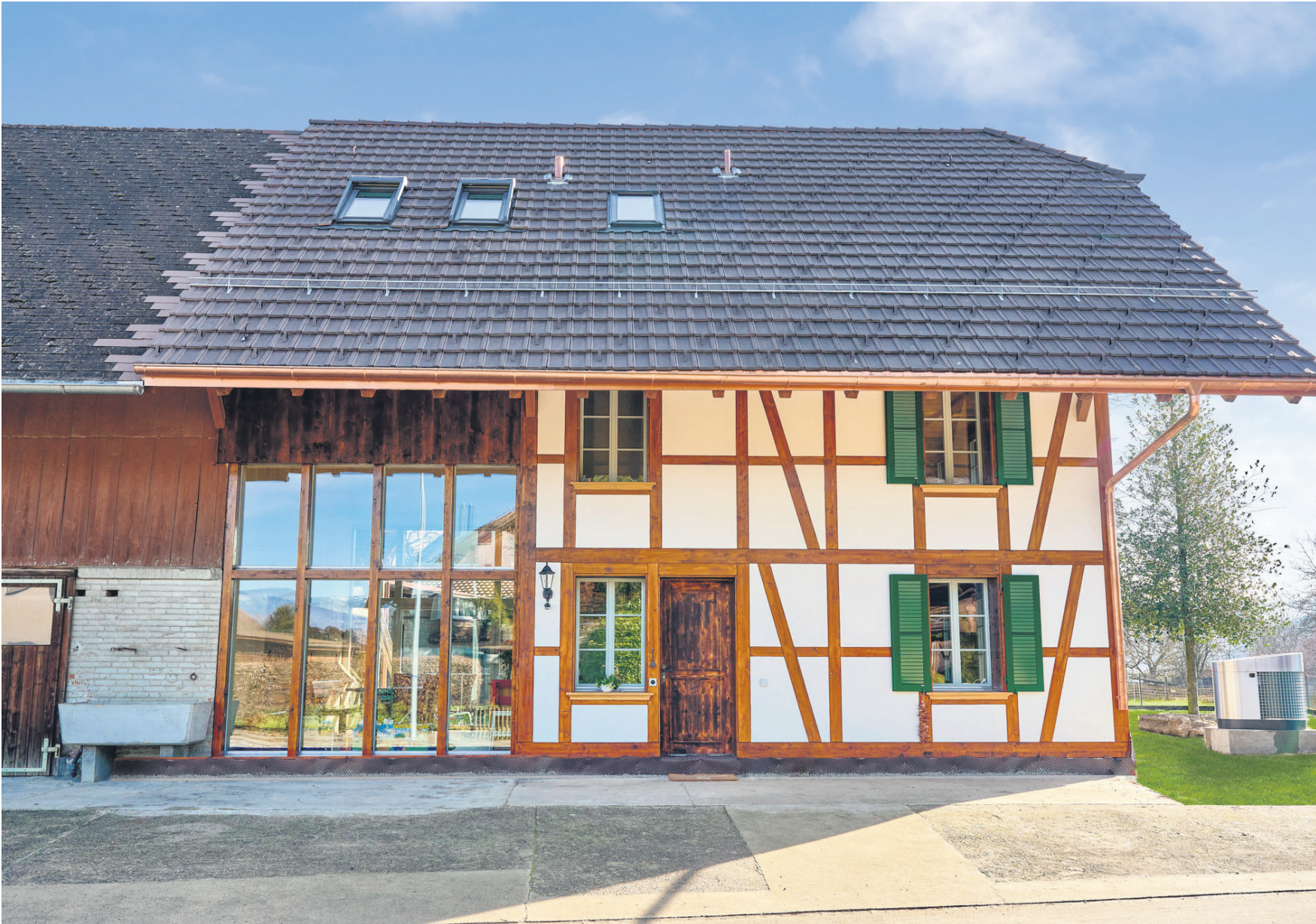
Eine frühzeitige Planung bildet die Grundlage für eine erfolgreiche Altbausanierung.
