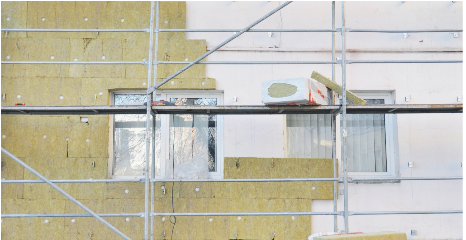
Mit der Abschaffung des Eigenmietwerts verändern sich die steuerlichen Rahmenbedingungen für Investitionen in die Energieeffizienz
