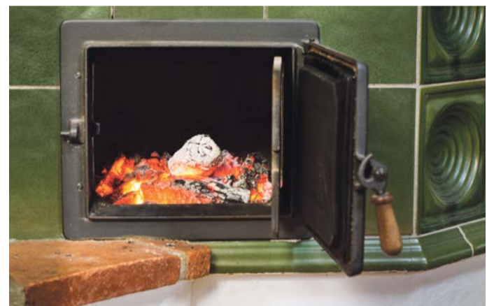
Dichtungsschnüre von Öfen oder Cheminées bestehen oft teilweise aus Asbest.
