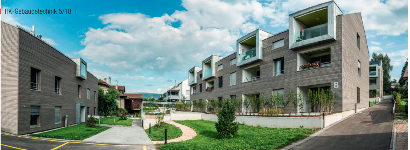
Überbauung «Muttimatte» in Brügg BE, welche die Firma Stuberholz als GU realisiert hat. Ökologisches Bauen und der Einsatz erneuerbarer Energien haben hier grosses Gewicht: Holzbau, kontrollierte Lüftung, Pelletsheizung, kombinierte Solaranlage für Warmwasser und Strom. (Bild: Mark Baumgartner)
