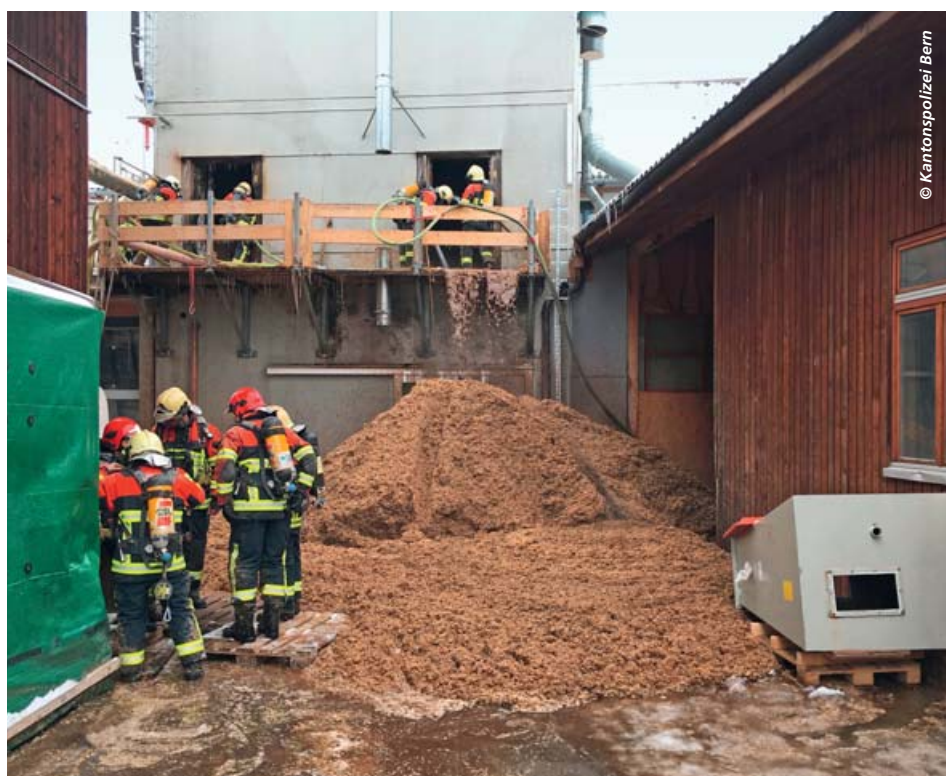
Herausfordernder Einsatz: Rund 40 Tonnen Holzschnitzel mussten die Einsatzkräfte aufgrund des Brandes aus dem Silo entfernen.
